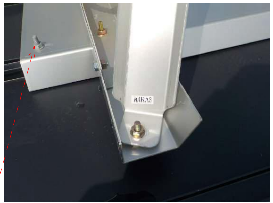
掴み金物ボルトに固定
